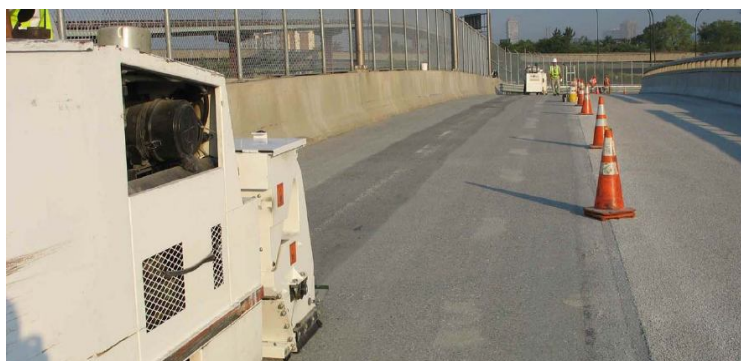
Рис. 2. Пример применения дорожной фрезы перед устройством антигололедного дорожного покрытия (США)
