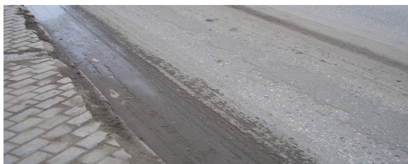
Рис. 3. Результат устранения выпоров колеи дорожной фрезой по силовому замыканию
