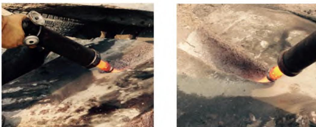
Рисунок 3.4 – Процесс работы термоинструмента ТРВ-12М1 с эжекционной насадкой
