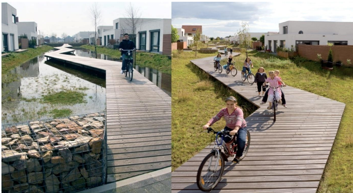
Рисунок 18. Накопление и инфильтрация воды в ливневом пруду
