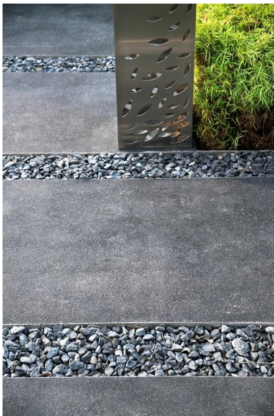
Рисунок 20. Поверхностная инфильтрация осадков через водопроницаемый тротуар
