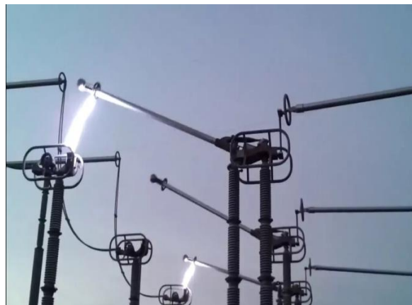
1.9 – сурет – PM-40-40 ABB типті айырғыш
