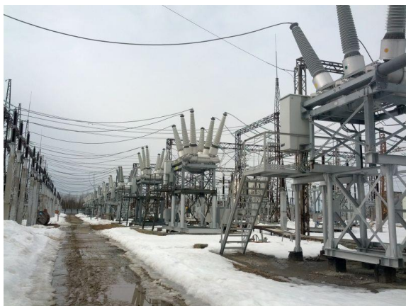
1.8 – сурет – GL 317 типті ажыратқыш
