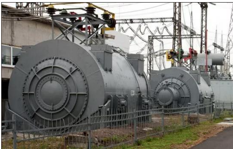
2.2 – сурет – Синхронды компенсатор
