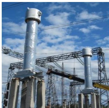
1.10 – сурет – ТГФ 500 типті ток трансформаторы
