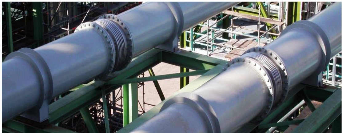
7 Сурет – Құбыр желісіне орнатылған компенсатор
