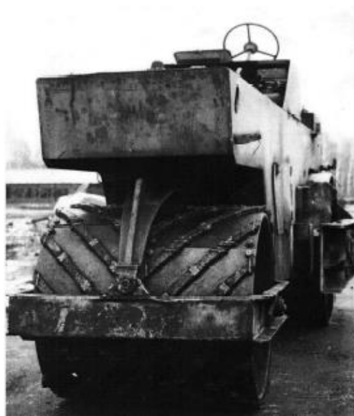
Рисунок 1.16 - Каток с ребристым ведомым передним вальцом
