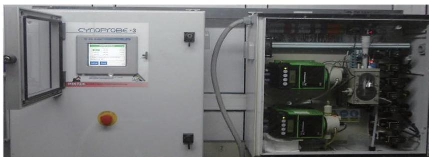
Рисунок 10 – Система автоматического контроля концентрации цианида в процессе выщелачивания на ЗИФ «Altyntau Kokshetau»
