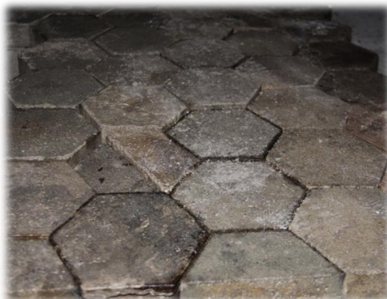
Рис. 2. Экспериментальный участок с выложенной полимерпесчаной тротуарной плиткой
