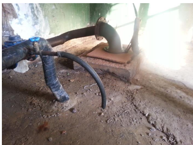
Шегендеуші құбыр диаметрі 324мм №564 ұңғыма оқпаны
