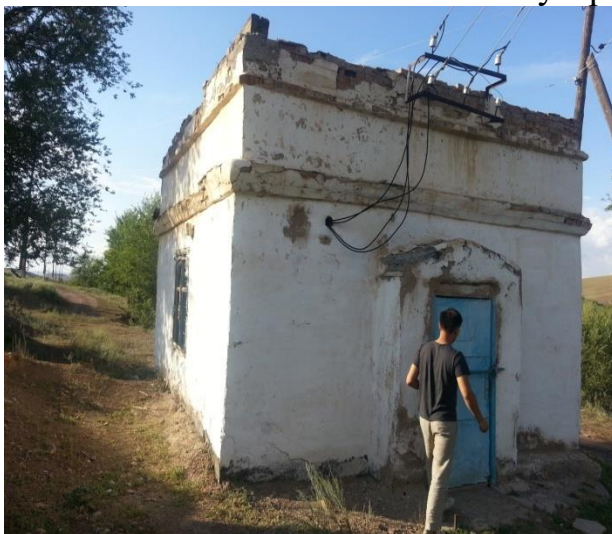
5x5x4м көлемдегі каптаж ғимараты
