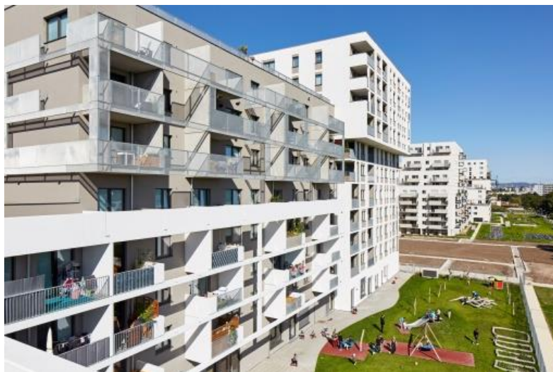
Рисунок 6. Общий вид на комплекс - Querbeet Social Housing / Synn Architekten. Фото© Манфред Зайдл.
