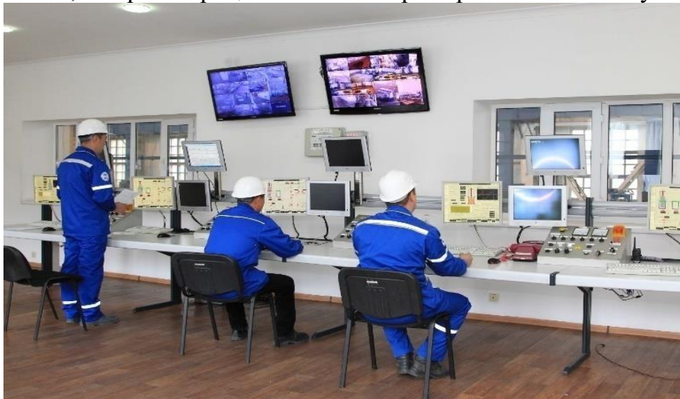
Рисунок 6 – Диспетчерская для дистанционного управления процессом ВДП переплава
