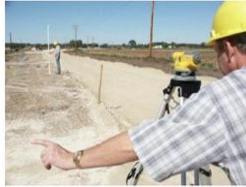
Сурет 5 - Ор жолдарға бағыт беруде электронды тахеометр және цифрлы нивелир қолдану
