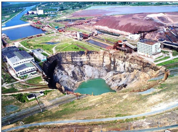
Рис.1.Провал на земной поверхности при отработке Верхнекамского месторождения калийно-магниевых солей
