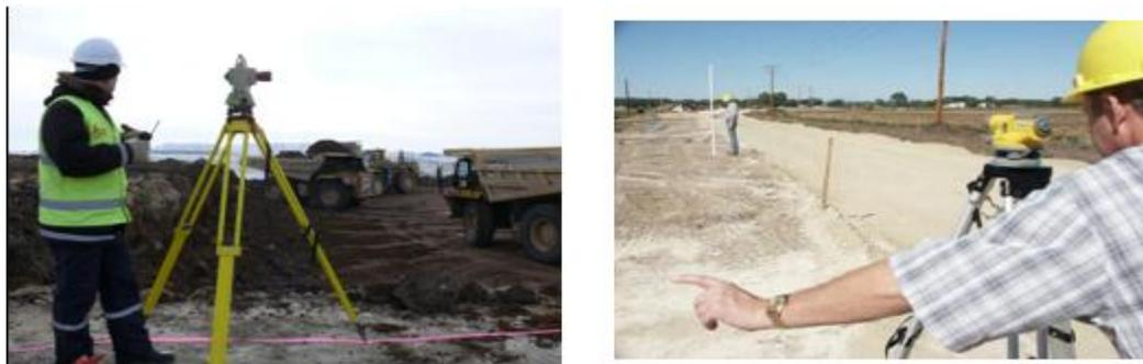
5-сурет. Ор жолдарға бағыт беруде электронды тахеометр және цифрлы нивелир қолдану
