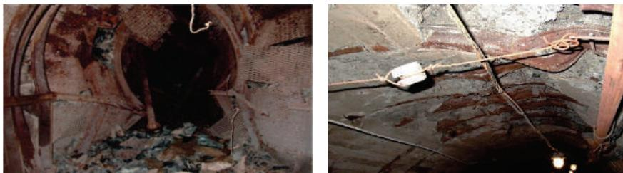
Рисунок 3 - Деформация элементов крепи.
