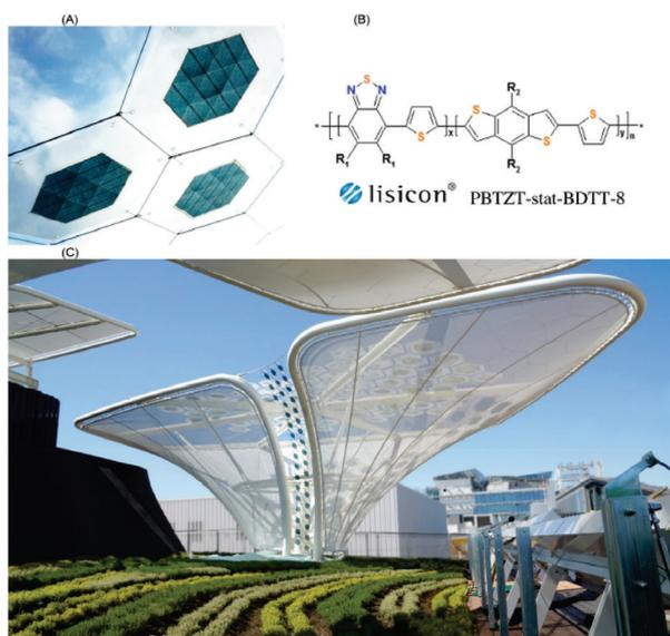
Рисунок 3 - Изображения А) коммерческого модуля OPV, изготовленного BELECTRIC OPV с использованием электродов ITO/METAL/ITO на пластиковых подложках, В) химической структуры используемого полимера: PBTZT-stat BDIT, С) крупномасштабного развертывания модулей BELECTRIC OPV на Всемирной выставке в Милане, 2015 г. [13].
