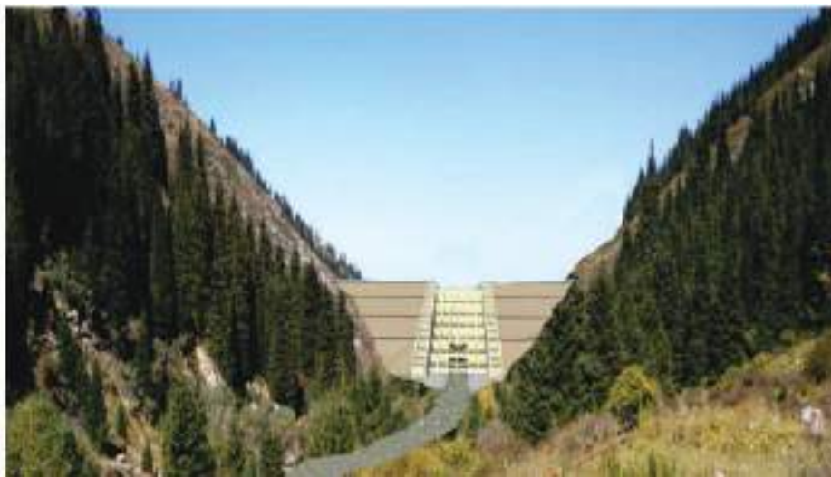
5-сурет. Үлкен Алматы өзеніндегі Аюсай шатқалының төменгі бөлігінде орналасатын (жоба) селұстағыш бөгетің макеті
