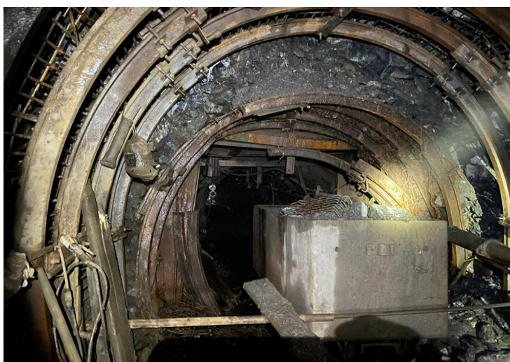
Рисунок 1.5 - Конвергенция крепи откаточных выработок
