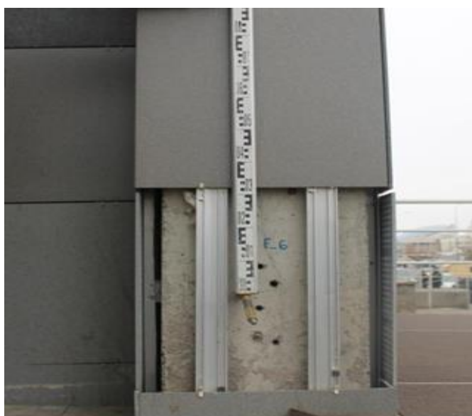
Сурет.3 - ғимарат бағаналарындағы мониторингтік нивелирлік нүктелер
