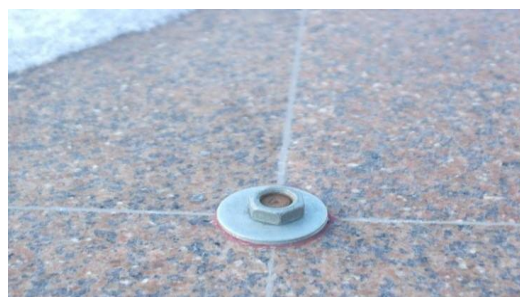
Сурет.3 - ғимарат бағаналарындағы мониторингтік нивелирлік нүктелер
