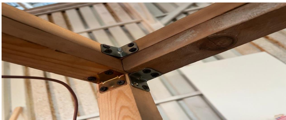
Рисунок 43 - Повышение прочности рамы
