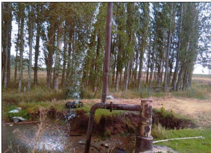
Д.13 - сурет – Талапты кентінің су алу құрылғысының өздігінен ағатын ұңғымасы
