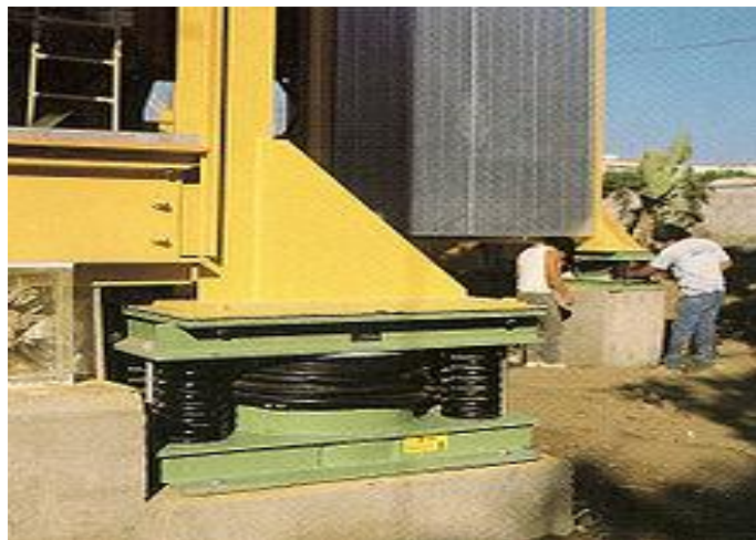
Рис. 6. Пружинный демпфер под трехэтажным домом
