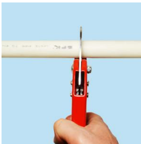
Рисунок 4. Резка трубы
