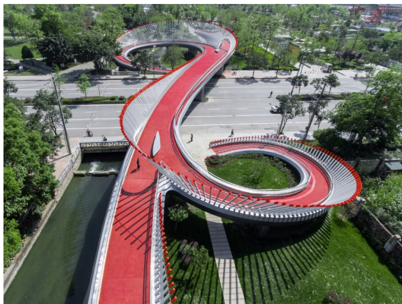
Рисунок 12. Общий вид пешеходного моста Ruiy в Китае
