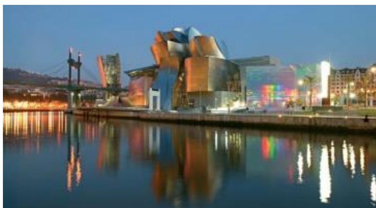
Рисунок 15. Фасад музея Гуггенхайма в Бильбао.
