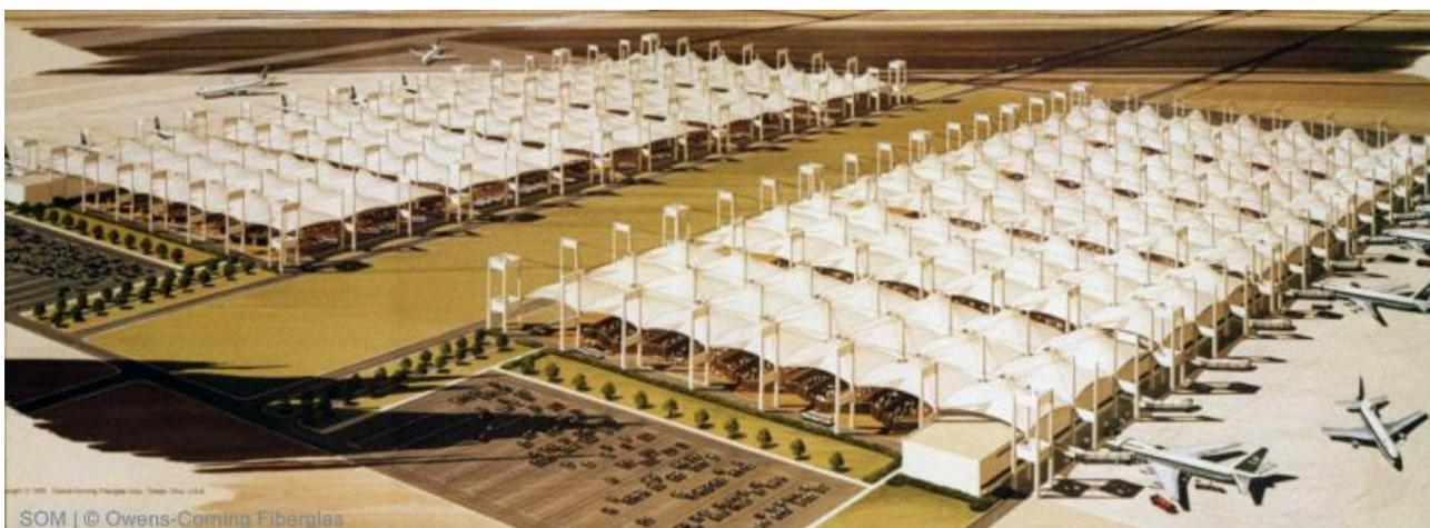
Рисунок 15. Тентовые конструкции терминала Хадж аэропорта имени Короля Абдул Азиза. Саудовская Аравия
