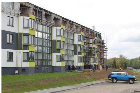
Рисунок 11. Пример модернизации пятиэтажных жилых зданий с надстройкой мансардного этажа и применением эркеров [10]
