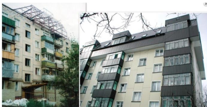
Рисунок 8. Пример модернизации пятиэтажных жилых зданий с надстройкой мансардного этажа [8]
