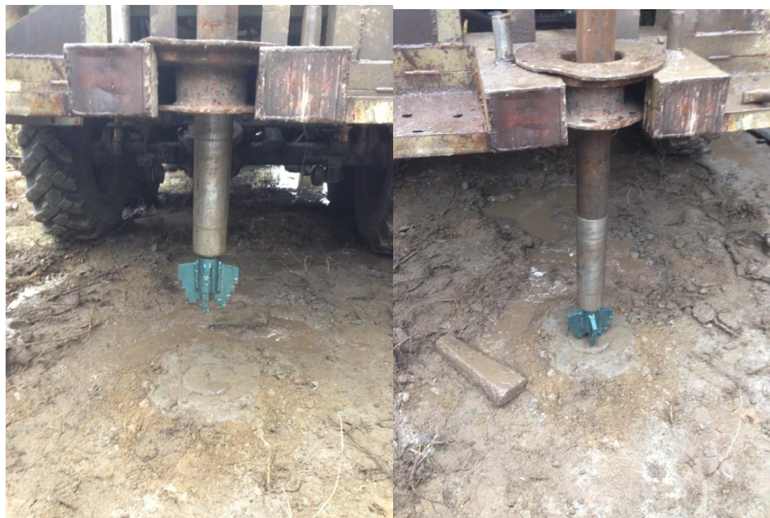
Рисунок 5.2 – Забуривание скважины опытным пикобуром
