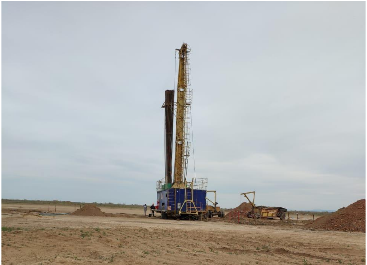
Рисунок 5.4 – Буровая установка БПУ-1200 конструкции АО «Волковгеология»
