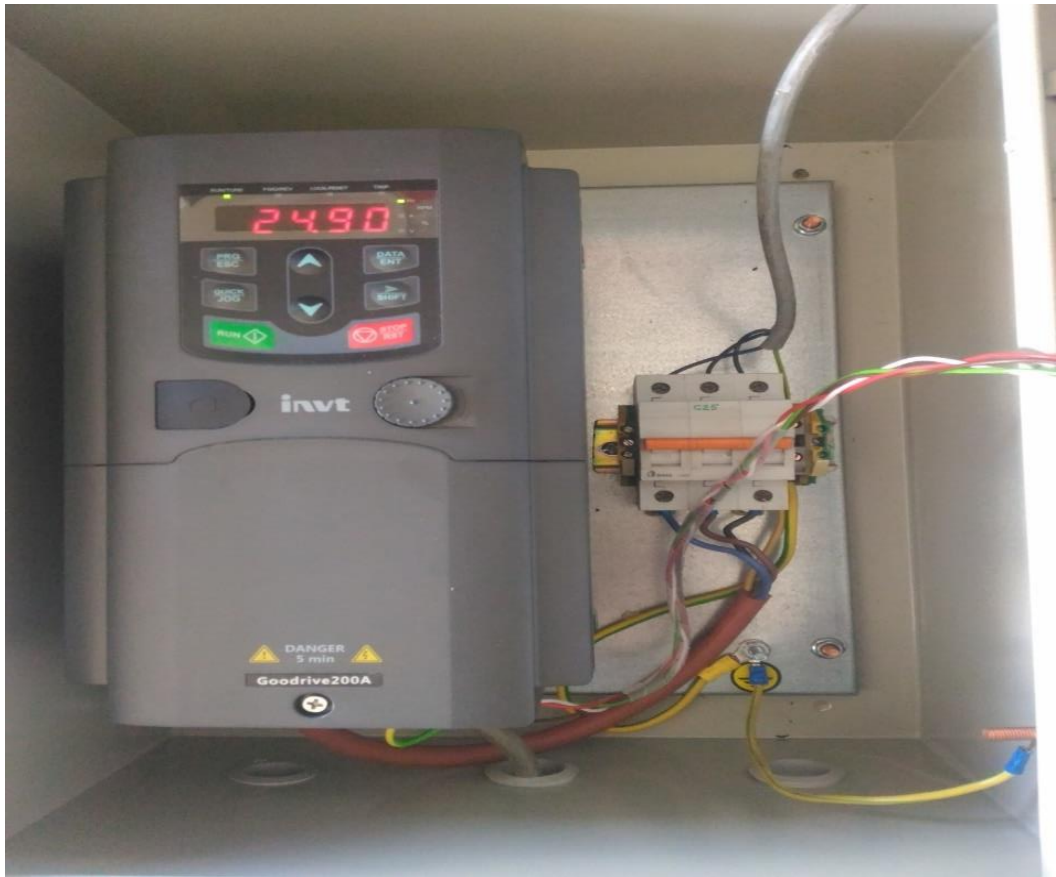
Рисунок 1.15 – Частотный преобразователь и вводной автомат
