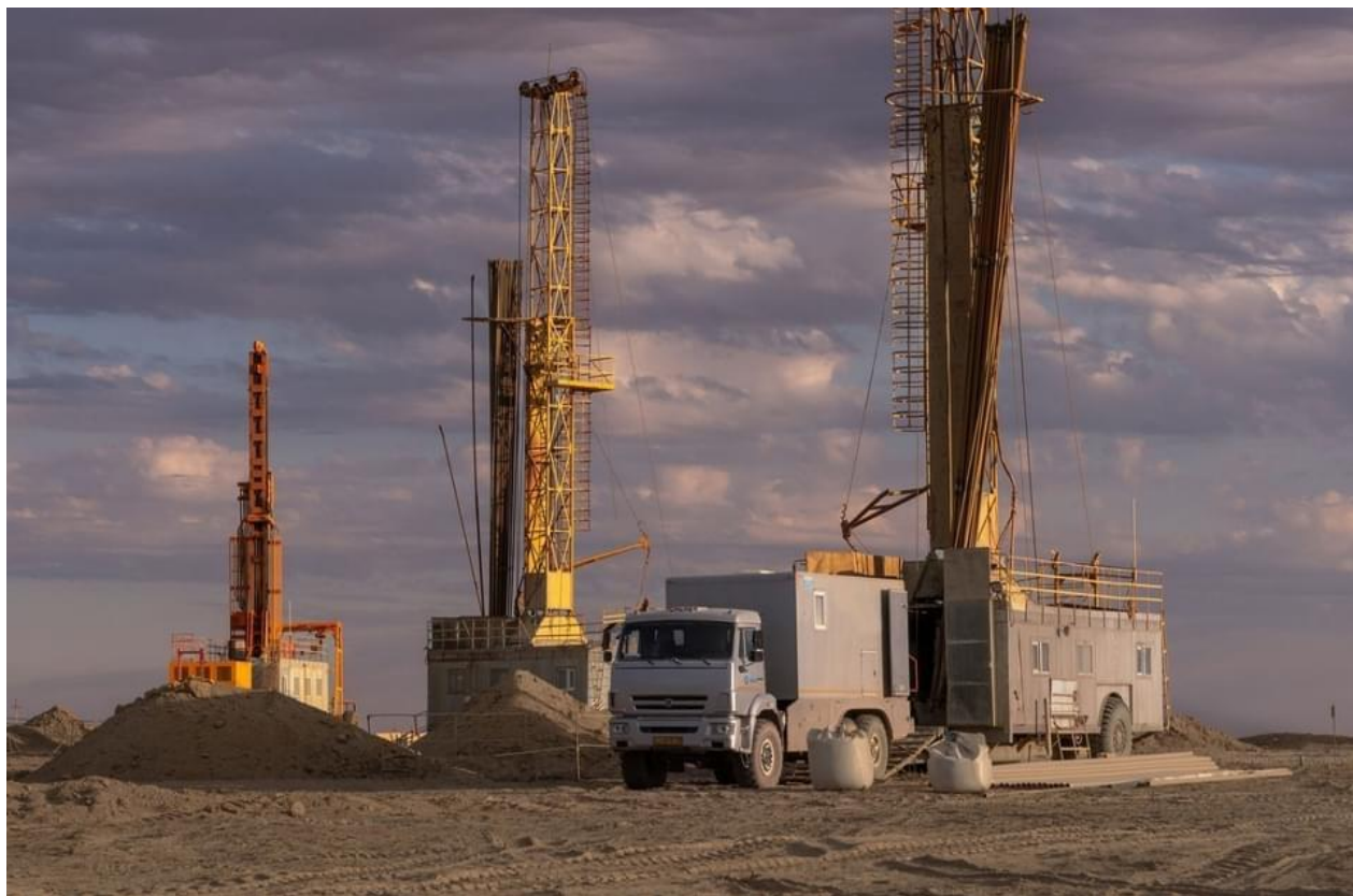
Рисунок 1.4 – Бурильная установка ЗИФ 1200
