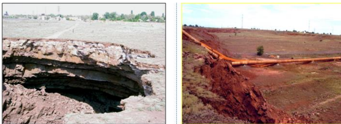
Рисунок 1.1 - Оседание земной поверхности Анненского месторождения в районе теплотрассы
