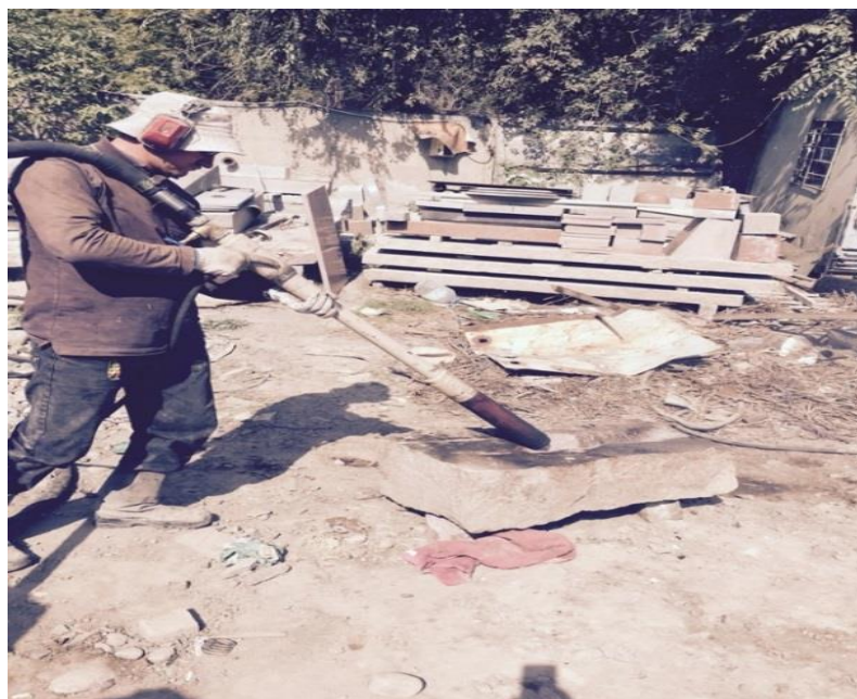
Сурет - 4.12. Тесік қазбаларын кесу кезінде БВР - 80А жұмыс процесі
