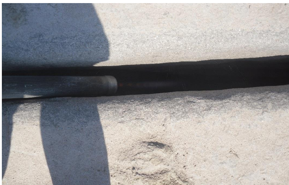
б) термоқұралмен тесік қазбаның түзілу фрагменті
