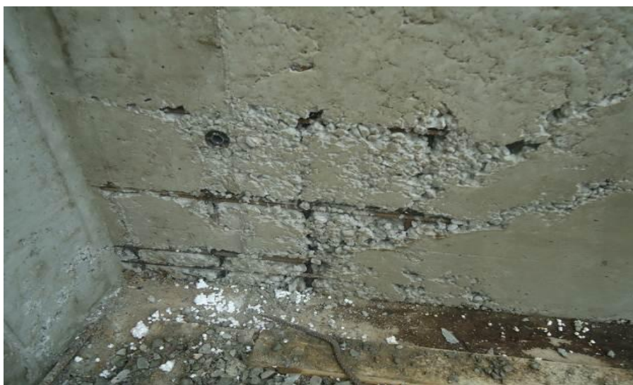
5 Сурет - Нығыздалмаған темірбетон құрылымының мысалы (қабырға)
