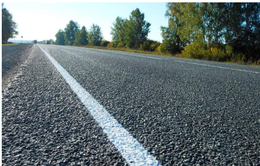
Сурет 1.2 - Битум мен қиыршық тасты бір реттік тарату арқылы беттік өңдеу
