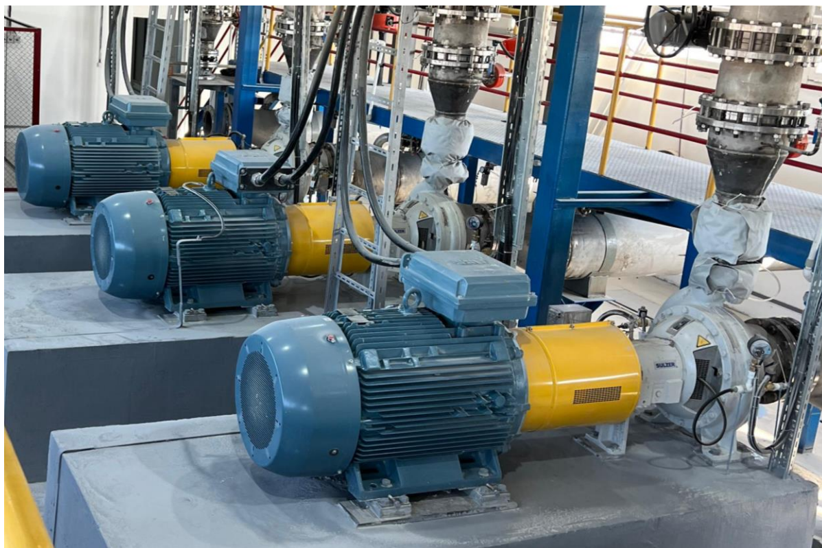
2 – сурет. Консоль түріндегі орталықтан тепкіш сорғы агрегаттары бар технологиялық сорғының жалпы түрі
