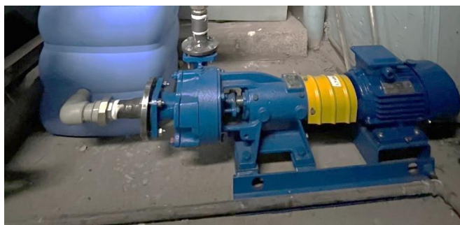
17 - сурет. 1K8 / 18 сорғы: а – сорғының жалпы көрінісі; б – 3D сорғы моделі
