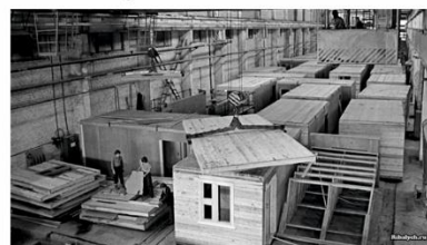
Сбор модульных блоков
