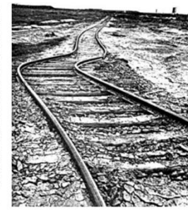
Деформация рельсового пути.
