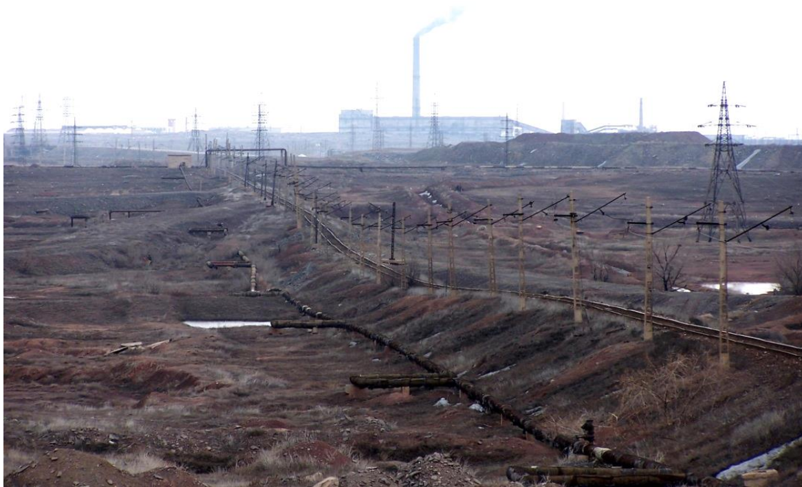
Сурет 21- Темір жол трассасының біртіндеп шөгуі
