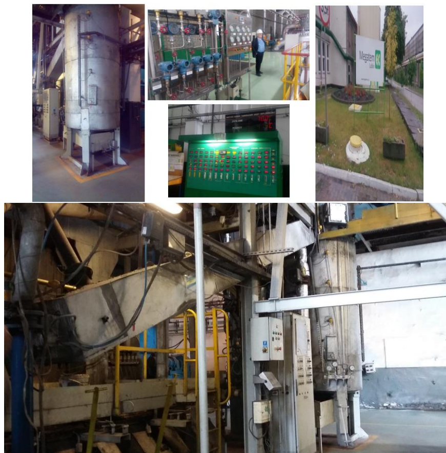
Рисунок 3.10 – Промышленная установка по сжиганию биогаза на ТЭЦ МEGATEM (г.Люблин, Польша)
