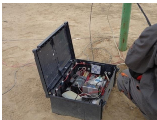
Рисунок 5.9 – Шкаф управления, включающий контроллеры Fatek, ОВЕН МЭ110 и модули МОХА.
