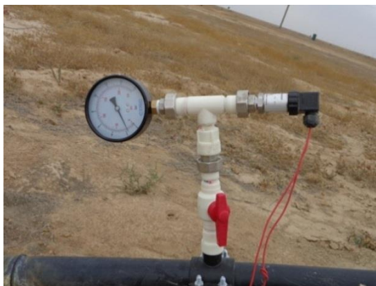
Рисунок 5.8– Измерение давления на выходе откачной скважины
