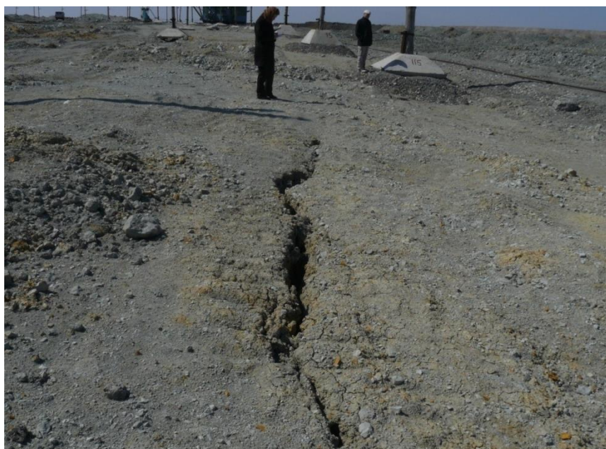
Сурет 2.20 - Тау жыныстары үйінділерінің жоғарғы алаңында жарықшақтардың пайда болуы
