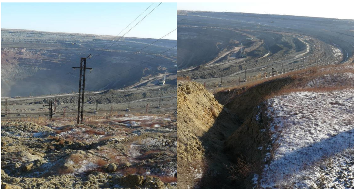
Сурет 4.5- Карьердің оңтүстік-батыс жақ беткейінің деформацияға ұшырған жері
