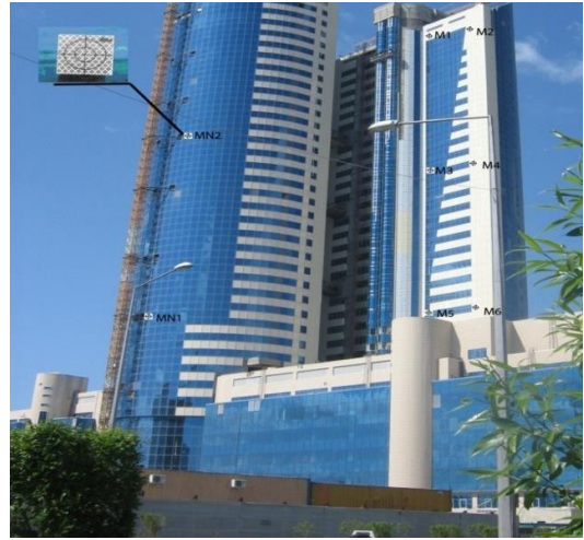
Сурет 4.13 – «Қазақстан темір жолы» мекемесі ғимаратындағы бақылау маркаларының орналасуы
