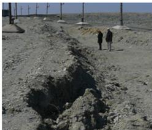
Сурет 4.7- Инженерлік құрылымдар мен құрылыс нысанының деформацияға ұшырауы
