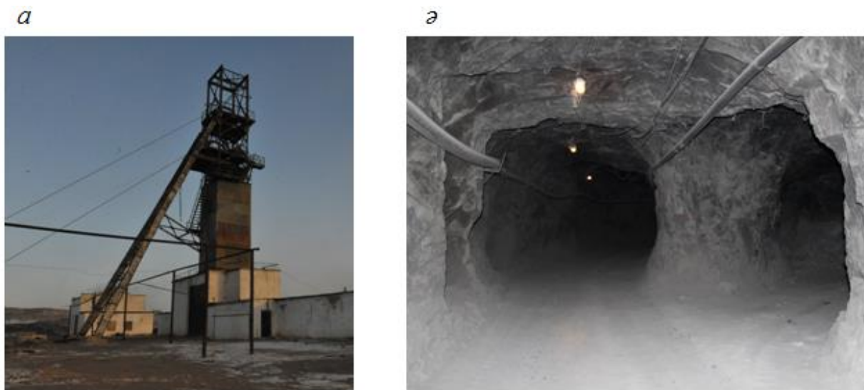
Сурет 2.2- а - кеніштің қосымша оқпанының сырт көрнісі; ә - бір-бірімен жалғасып жатқан жерасты қазбалары
