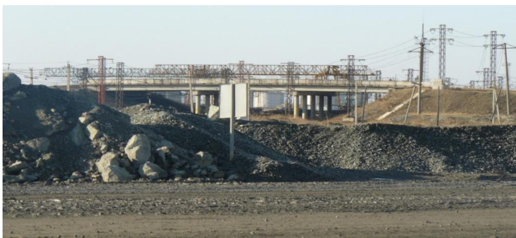
Сурет 4.8- Өнеркәсіптік алаңдағы көпірөткелі (путепровод); көпірөткелінің құрылысы
