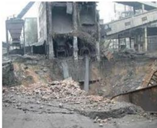
Сурет 4.7- Инженерлік құрылымдар мен құрылыс нысанының деформацияға ұшырауы
