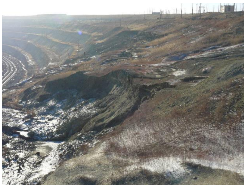
Сурет 4.5- Карьердің оңтүстік-батыс жақ беткейінің деформацияға ұшырған жері
