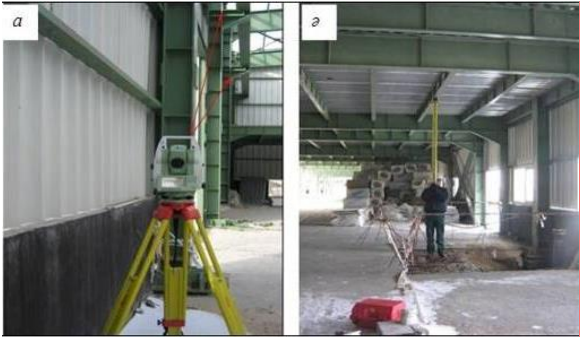
Сурет 4.20– Байыту фабрика конструкцияларының деформацияларын анықтау
