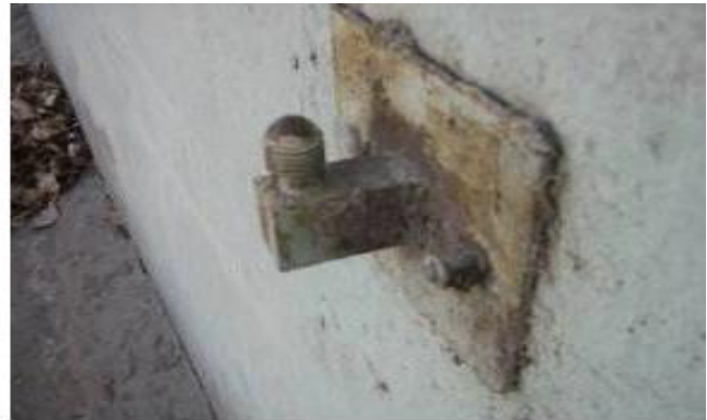
Сурет 4.14–Мониторингтік призма және шөгу маркасы
