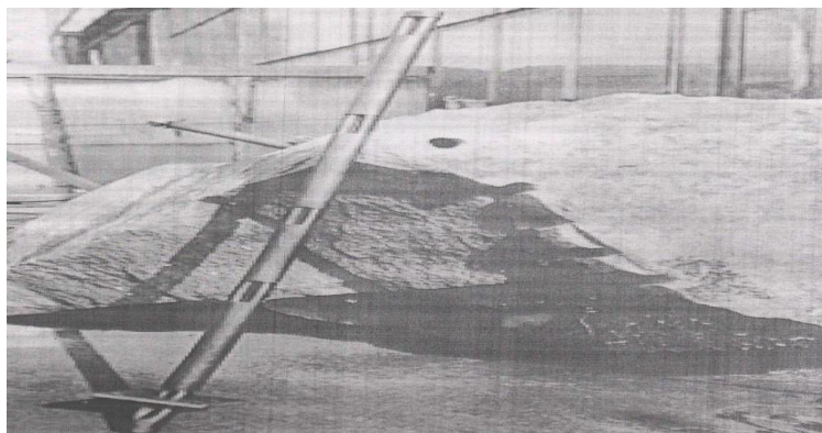
Рис. 2.11 - Стенд с металлическим имитатором шпура
