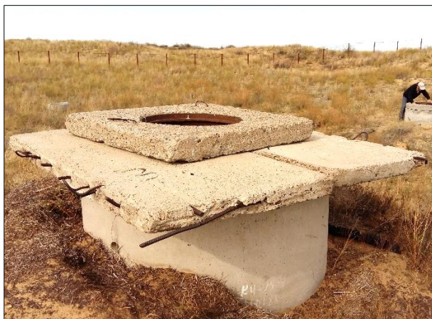
Рисунок 5.31 - Фото автора - Типы каптажных сооружений (скважины) на территории песков Нарын
