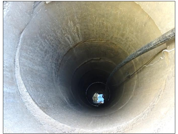
Рисунок 5.30 - Фото автора - Типы каптажных сооружений (бетонные кольца) на территории песков Нарын
