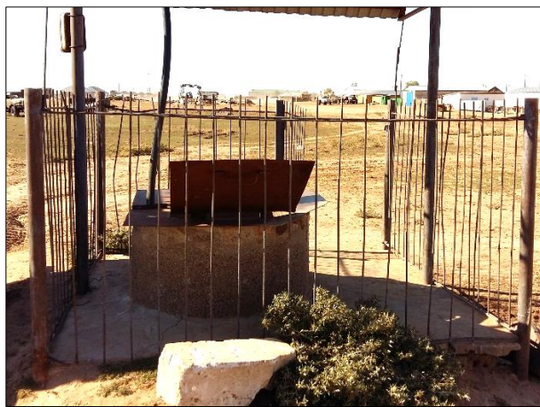
Рисунок 5.30 - Фото автора - Типы каптажных сооружений (бетонные кольца) на территории песков Нарын
