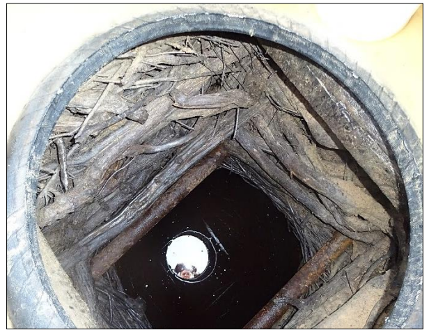
Рисунок 5.29 - Фото автора - Типы каптажных сооружений (деревянные) на территории песков Нарын
