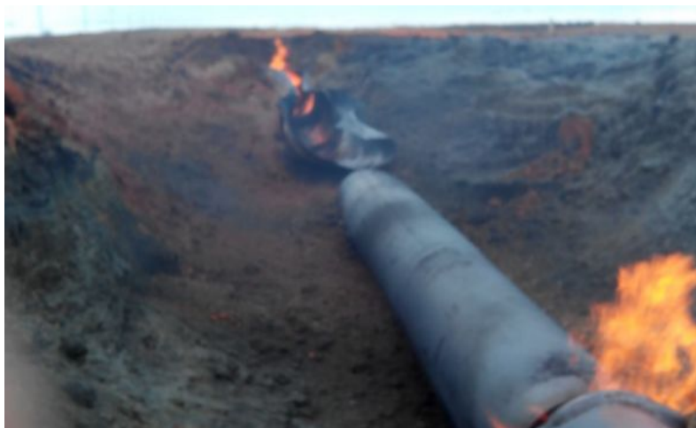
Рисунок 1.21 - Разрыв с возгоранием на участке 283 км магистрального газопровода "Оренбург-Новопсков"[15]
