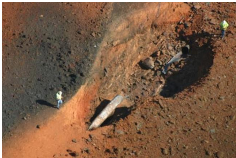
Рисунок 1.22 – последствия аварии на магистральном газопроводе в г.Гринсберг [16]
