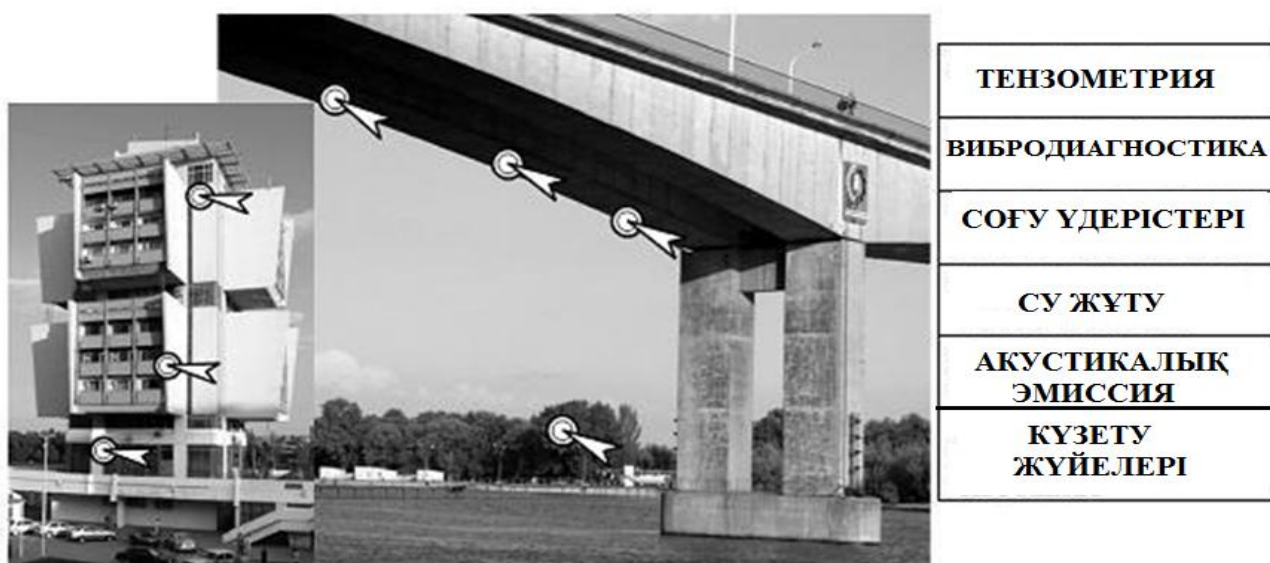
Сурет 1.5 - БМЖ–де ФШД қолданылатын көпірлі құрылыс мысалы
